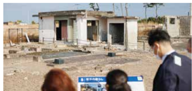
すさまじい威力の水流が破壊した住宅跡
