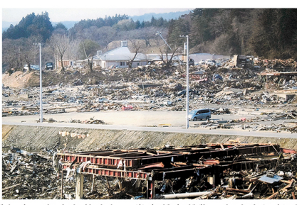
大宮津波被害を受けた福祉センター(11年11月撮影) (宮城)津波被害を受けた福祉センター(11年11月撮影)
