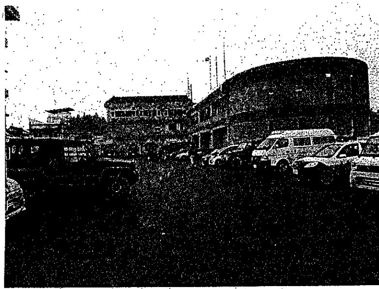
防災センターの様子です
