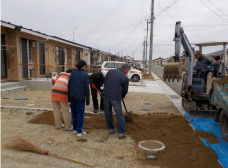
↑みんなで土入れ作業！
