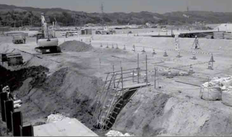
新市街地の西(山手)側は雨水排水工事と盛土工事を行っています
