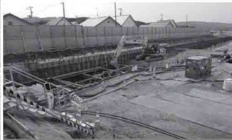
第2期の住宅脇は農業用排水路の付替工事中
