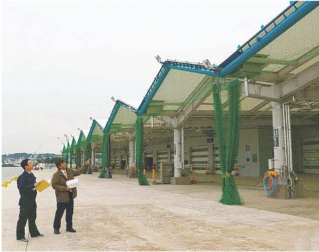
完成した魚市場南棟Ⅰ期。水揚げの拠点施設となる =31日、塩釜市
