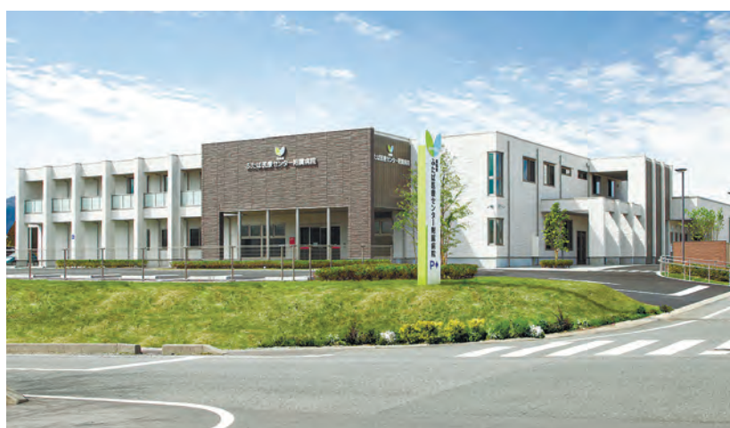
救急医療拠点の整備が急がれる中、短工期での建設を実現した福島県ふたば医療センター附属病院
