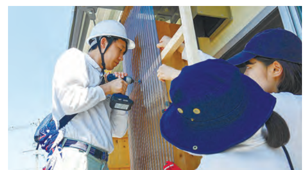
新入社員による被災地の支援活動として、仮設住宅の風除壁設置作業を行う様子。東日本大震災の翌年から毎年、被災地の復興支援に取り組んでいます
