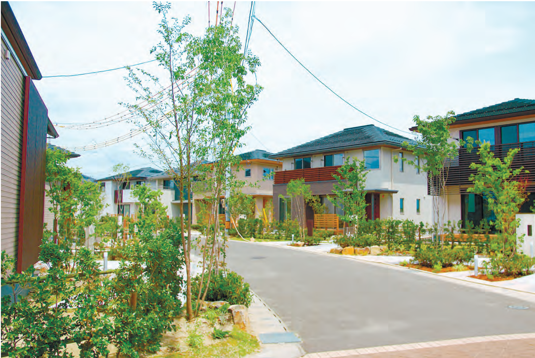
「スマートコミュニティ明石台」では、太陽電池、燃料電池、蓄電池を積極的に導入するなど、東日本大震災を教訓とした「安全・安心」なまちづくりを推進。豊かなコミュニティの形成、美しいまちづくりにも力を入れています
