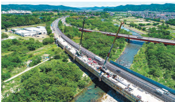
老朽化や大型車両の増加などにより傷んだ高速道路において、橋を架け替えるなどの大規模なリニューアル工事を進めています
