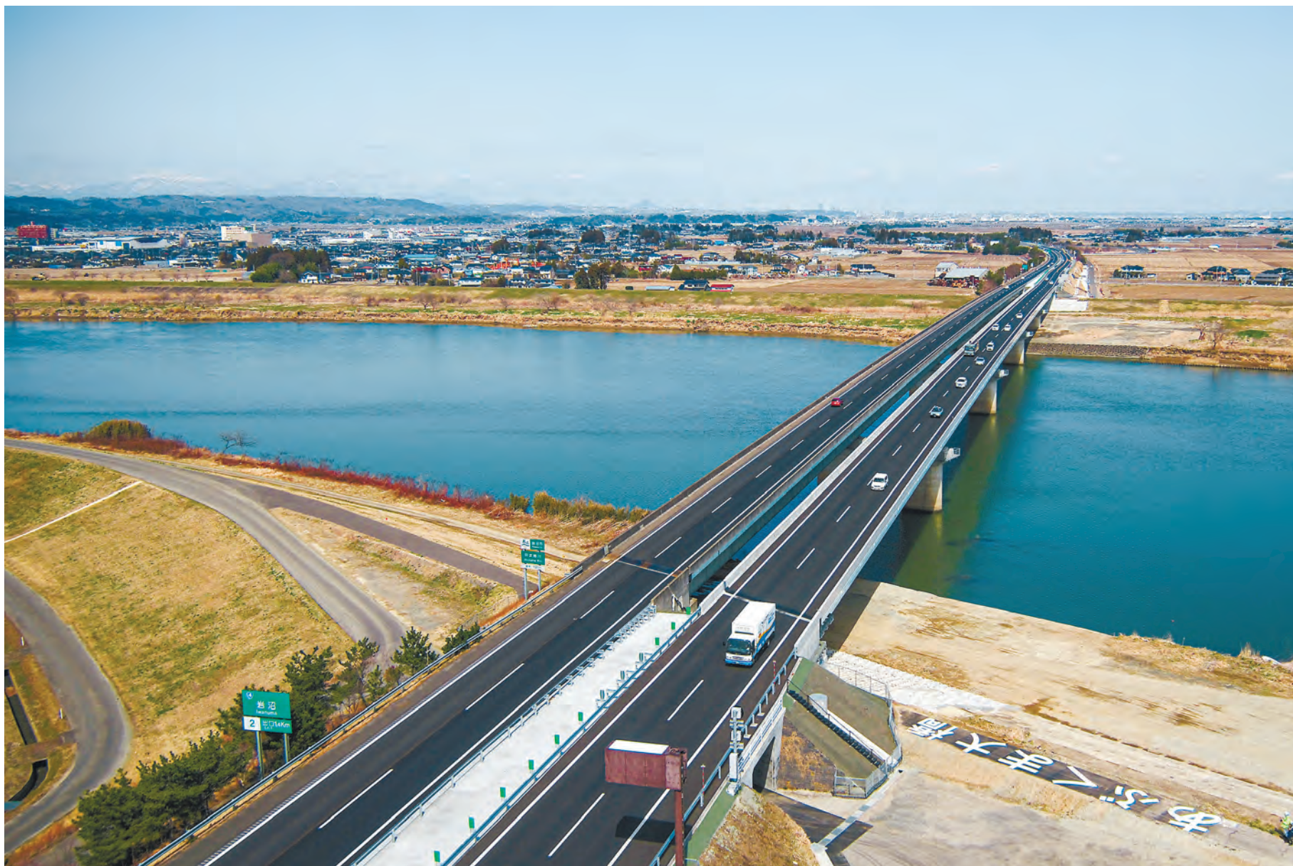
4車線化工事が完了した常磐自動車道山元―岩沼IC間の阿武隈大橋付近。今年3月6日より4車線通行が可能となりました。 安全性向上による交通事故の減少や渋滞緩和など、さまざまな整備効果が期待されています
