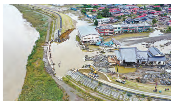
令和元年東日本台風により大郷町を流れる吉田川の堤防が決壊。宮城県建設業協会の会員企業が応急復旧にあたりました(2019年10月14日撮影)
