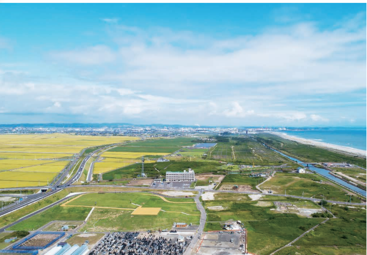
東日本大震災の津波で甚大な被害を受けた仙台市東部地域では、海岸堤防、海岸林、東部復興道路(かさ上げ道路)、避難の丘、避難タワーなどが整備された。多重防御の要とされる復興関連事業を、多くの地域建設業が支えてきた
