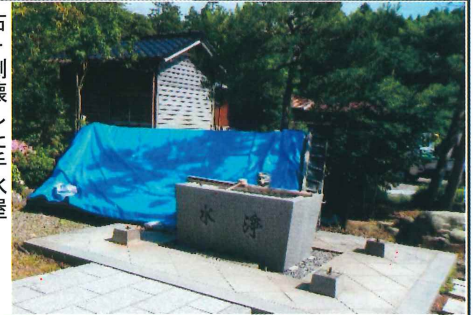
右:倒壊した手水屋
