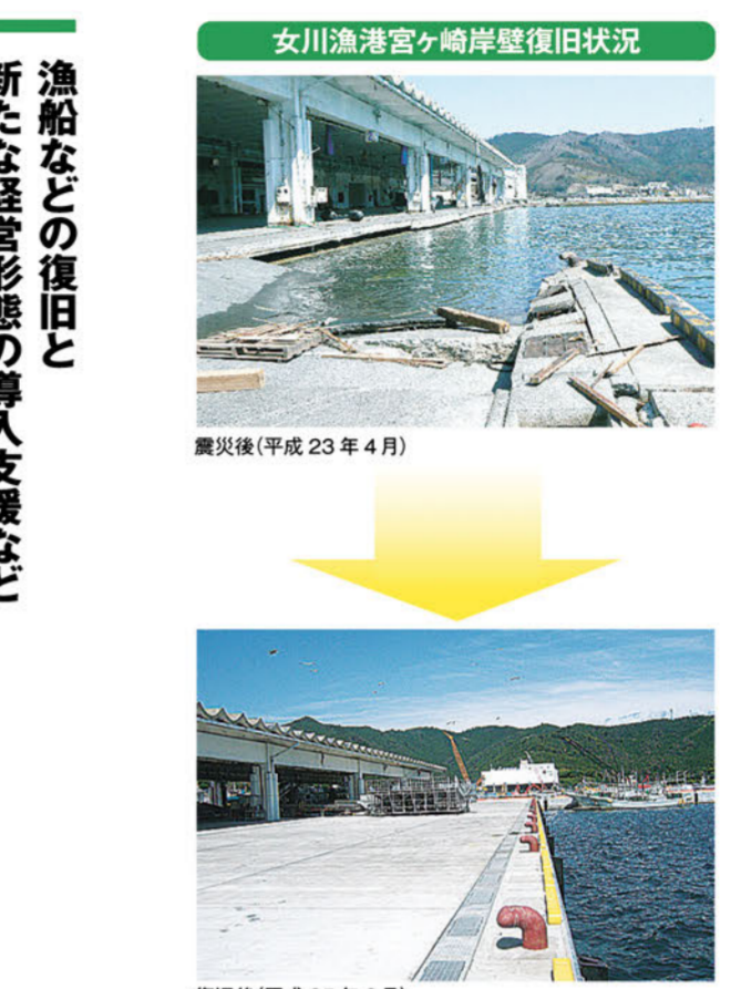
復旧後(平成25年6月)
