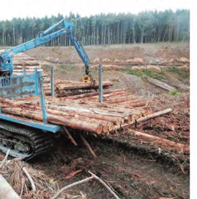
伐採した杉を運搬車に積み込む作業。残った枝や木をまとめて整理を行う地掃も同時並行して行う=大崎市岩出山池月
