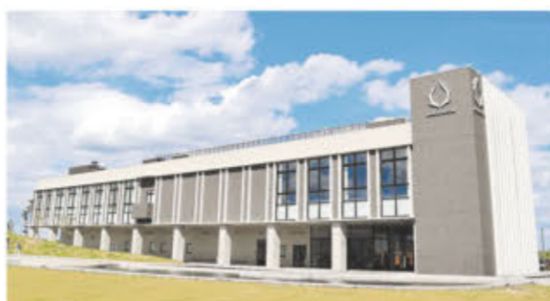
地中熱などの熱利用システムを導入したアクアイグニス仙台
