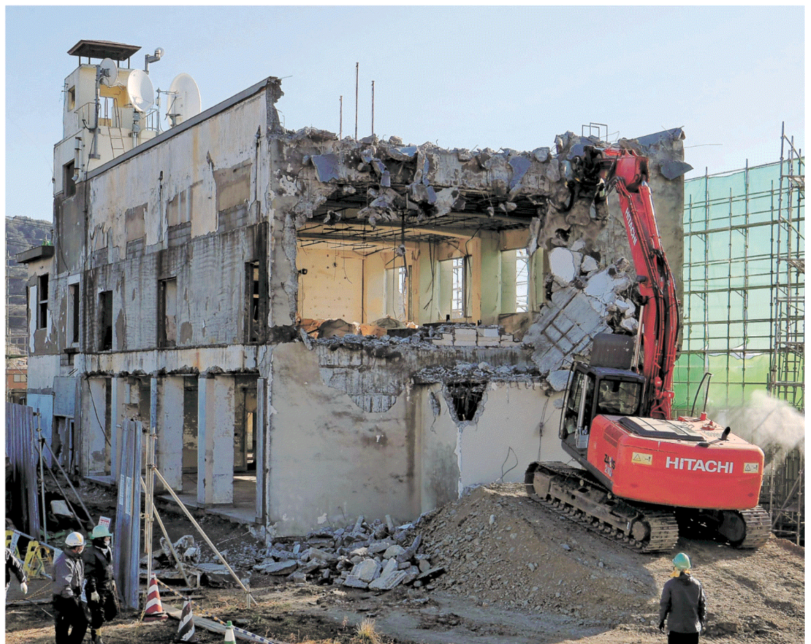
本体解体工事が始まった大槌町の旧役場庁舎＝19日
