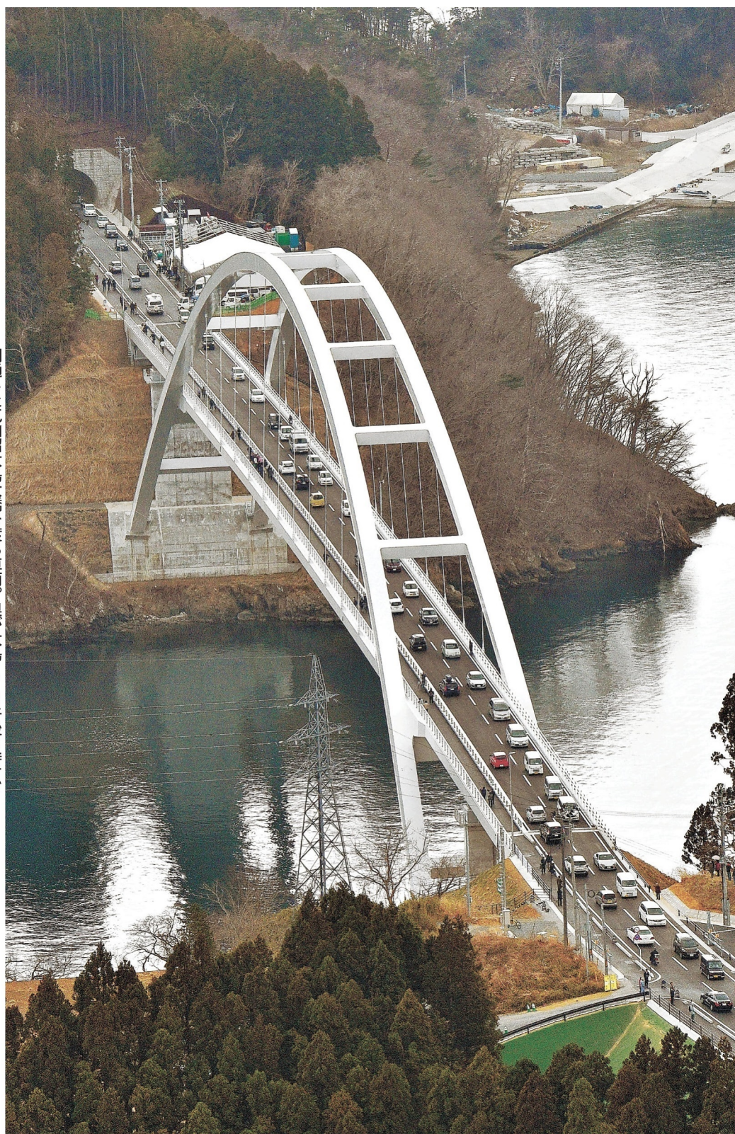
開通した気仙沼大島大橋を渡る車両。奥が大島。7日午後3時すぎ
