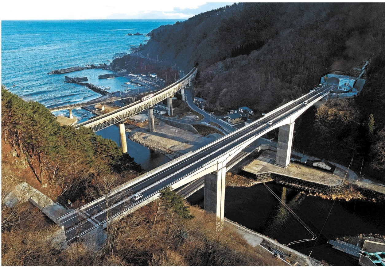
全線開通した三陸道の下安家大橋（手前）。海側の鉄橋は三陸鉄道リアス線。18日午後3時10分ごろ、岩手県野田村
