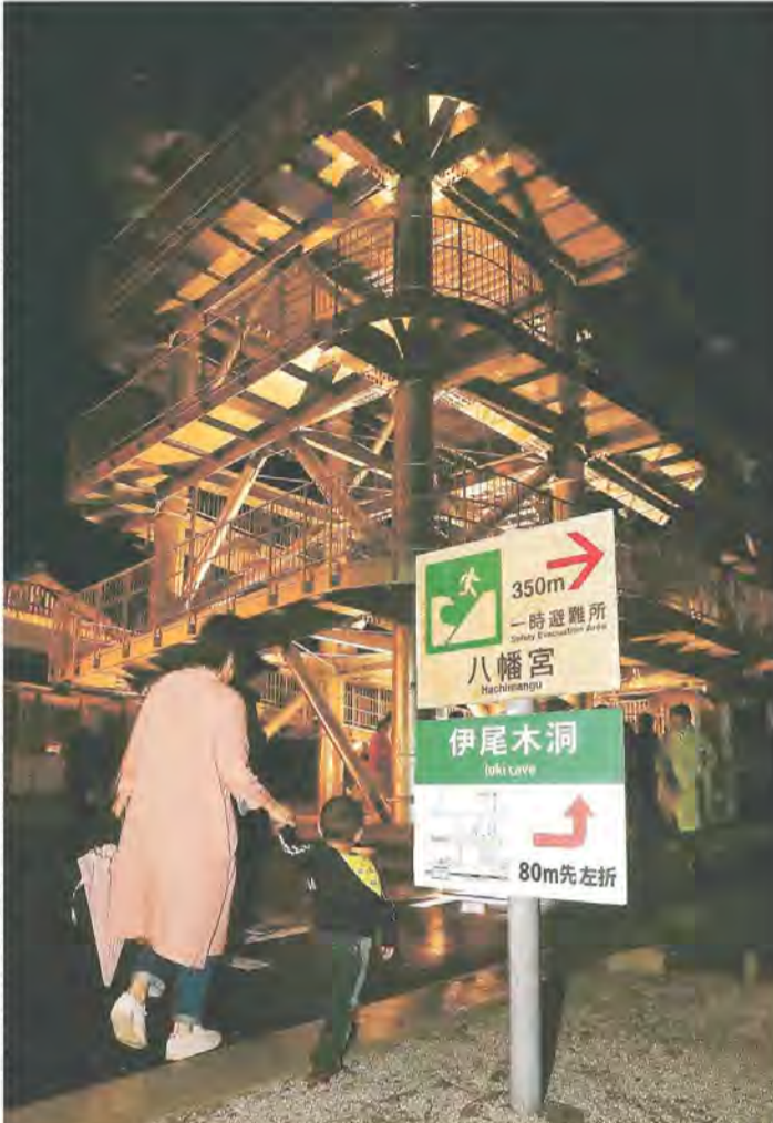
高さ20メートルの津波避難タワーに向かう避難路。10月28日午後8時40分ごろ、高知県安芸市伊尾木
