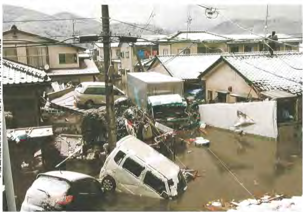
津波で浸水し、車なが流された石巻市鹿島南地区。2011年3月11日夕(西村さん提供)
