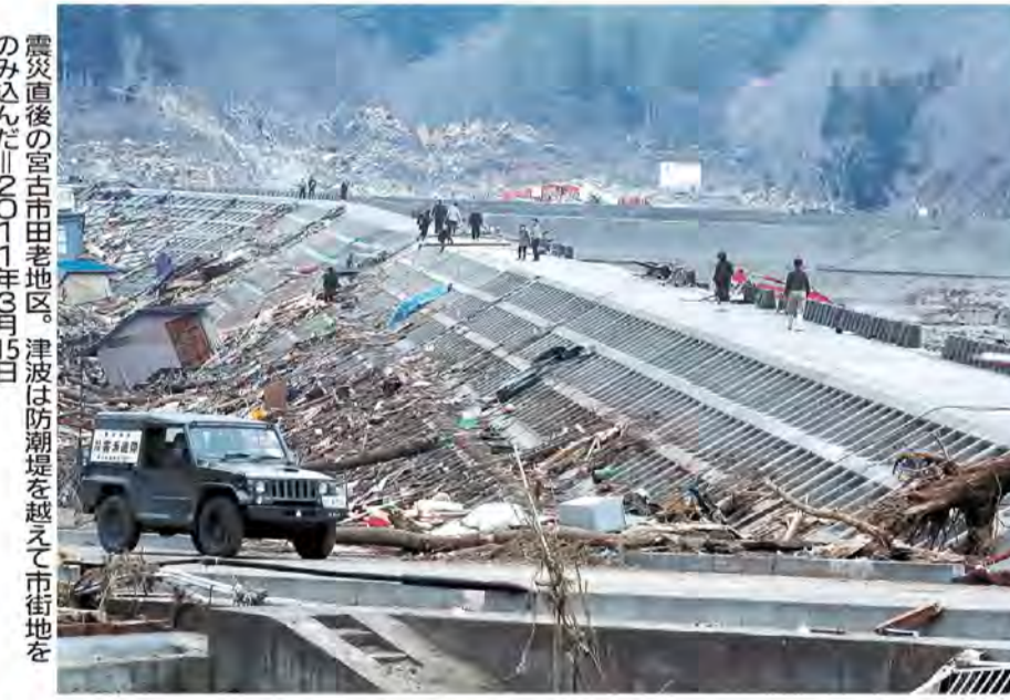
震災直後の宮古市田老地区。津波は防潮堤を越えて市街地をのみ込んだ。2011年3月15日
