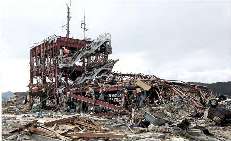
津波で無残に大破した南三陸町の防災対策庁舎。2011年4月
