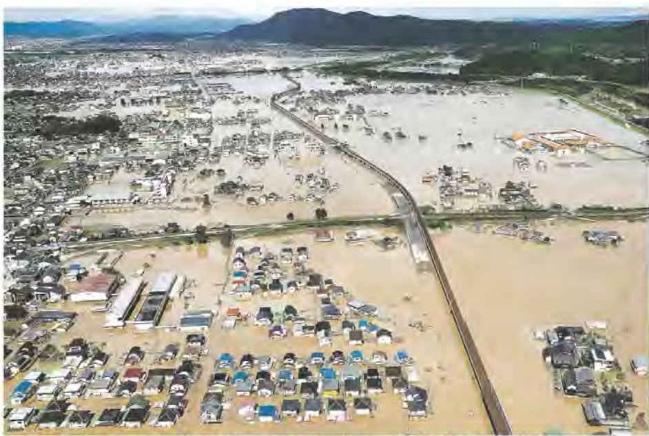
水に漬かった岡山県倉敷市の真備町地区。右奥にある下水処理施設も水没した=7月8日
