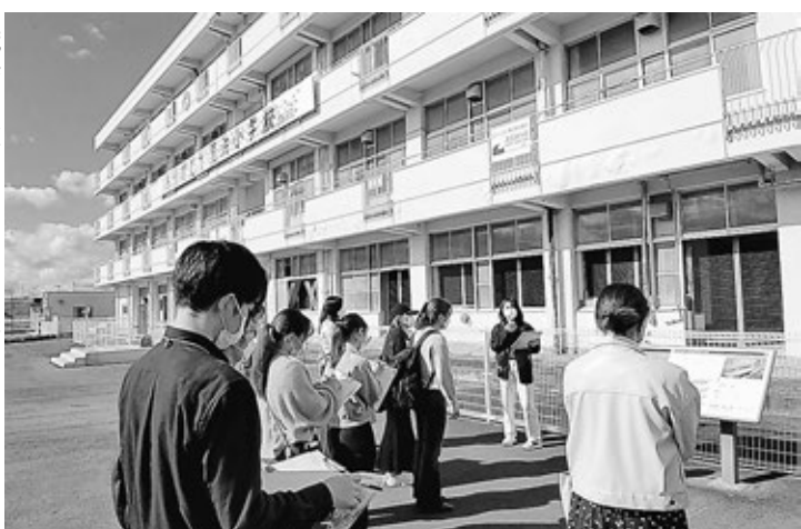
荒浜小の被害について話す矢崎さん 8日、仙台市若林区
