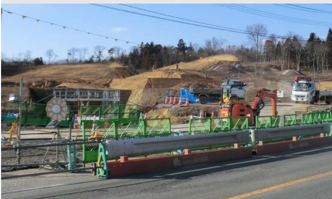
▲国道の拡幅工事中です。造成工事も順調に進んでいます。
