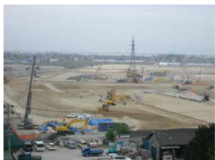
▲新市街地全体造成工事
