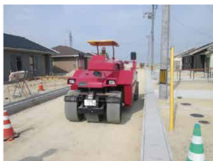
▲災害公営住宅地の区画道路工事
