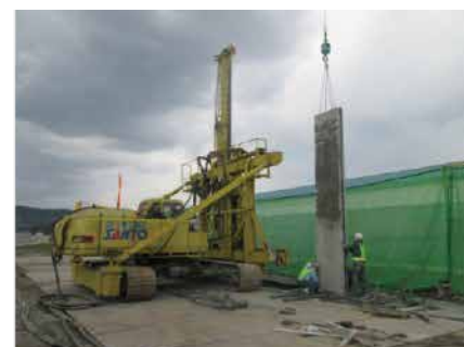
▲水路工事における矢板設置
