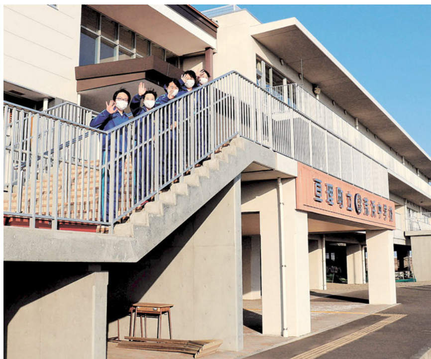
再建された巨理町荒浜中の校舎。津波被害を防ぐため1階部分が柱だけのピロティ構造(こうぞう)になっている
