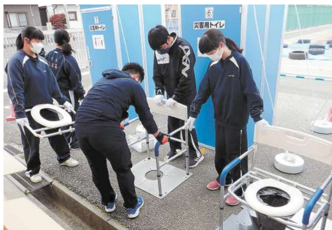
マンホールトイレを設置(せ)つえいする東松島市矢本一中の生徒たち 直径30センチほどのマンホールのふたを開け、便座を設置します
