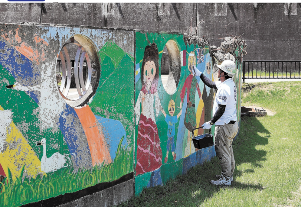
壁画の上に紫外線を防ぐ塗料を重ね塗りする作業員
