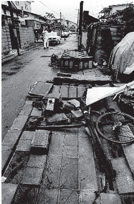
横倒しになったブロック塀 1978年6月12日、仙台市内
