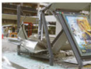
五橋バス停にビルの外壁が落下
