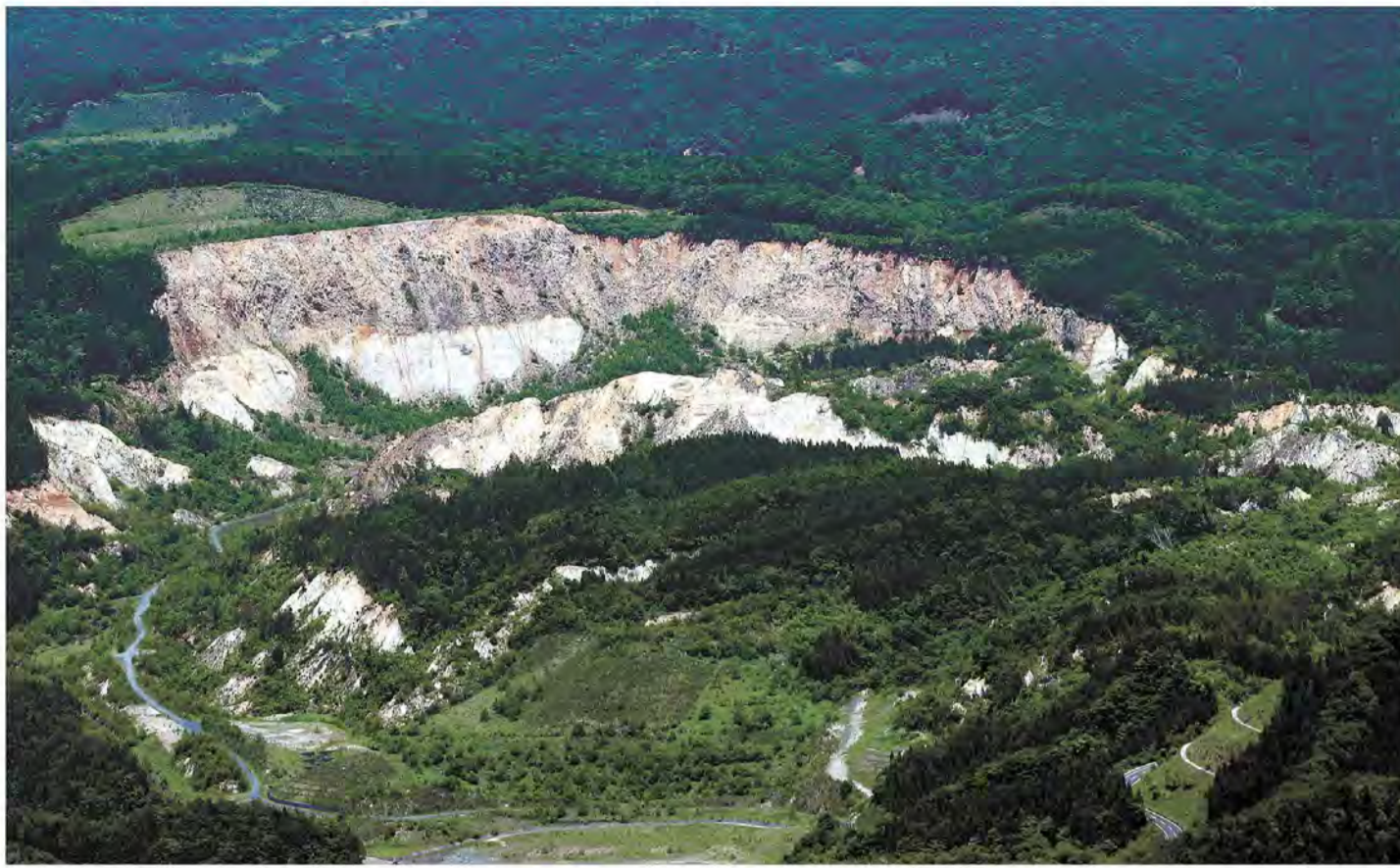
国内最大級の大規模地滑りが発生した栗原市栗駒の荒砥沢地区。斜面の傾斜は約130度、崩れ際の落差は最大150mに及ぶ。10年が経過した今も、山肌はむき出しになっている(13日)
